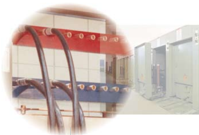
汇流排连接 Busbar connection ブスバーへの接続例
